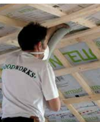
Die Hohlräume zwischen Dachsparren oder Deckenbalken lassen sich gut mit Zellulose füllen
