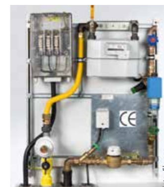
Die gesamte Hausversorgungstechnik ist platzsparend auf kleinstem Raum konzentriert
