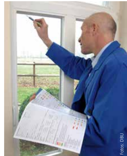
Vor 1990 eingebaute Fenster, lassen bis zu sechs Mal so viel Wärme durch wie moderne Wärmeschutzgläser
