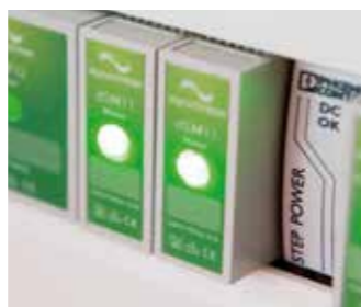
Der digitalSTROM-Meter regelt im Sicherungskasten die Kommunikation der Klemmen in einem Stromkreis
